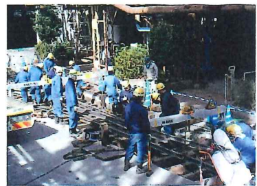
工場内の軌道等の敷設・整備を行う
